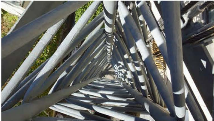
↑写真9／塗装後タワー内部。施工後、約5年経過したがサビがまったく発生していない。
