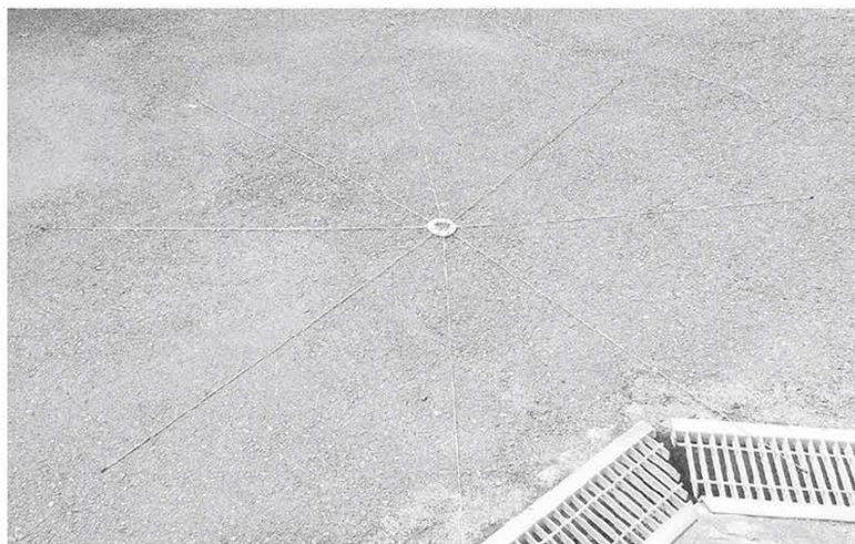
↑写真9 / カウンターポイズを装着したところ。広いところで作業したい。
