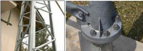
↑防錆処理を行っているので、サビなどは見られない。こうしたメンテナンスも重要だ。
