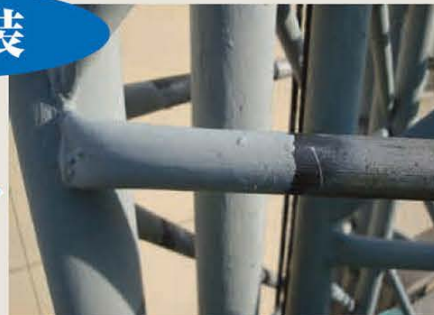
↑写真8／塗装後。ローバルは2回塗りが原則。厚いほど防錆効果が高い。
