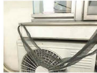
↑写真10 / アースは、アンテナ基台から網線で窓枠サッシのネジへ。
