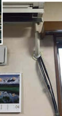
↓写真3/同軸はクーラー用のスリッパ穴を利用してベランダへ出している。
