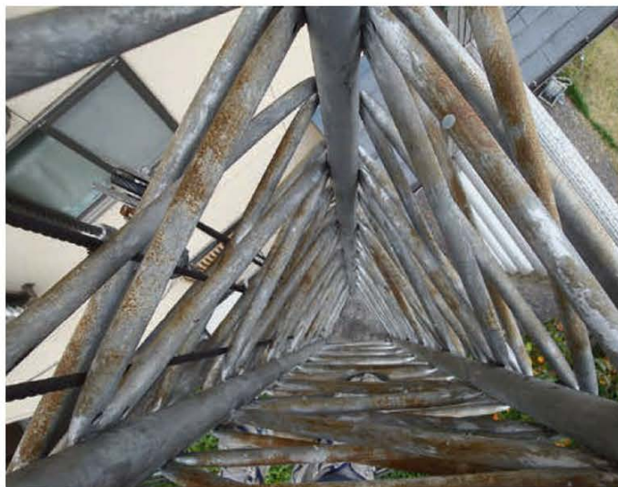
↑写真2／サビが進み、部品が破損している状態。
