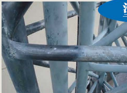
↑写真7／塗装前。不純物を除去し、清浄な金属面を出した状態。
