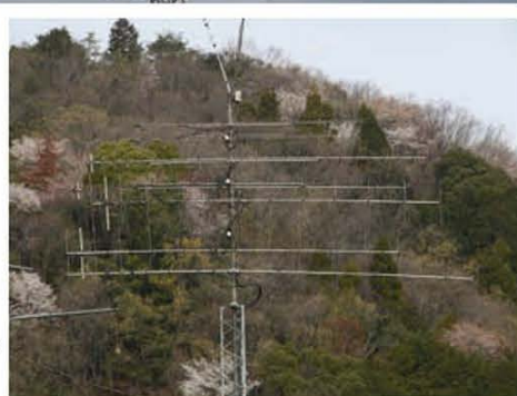
↑39mHのタワーのトップには全長25.8mの1.8/1.9MHzロータリーダイポール。その下には遠くからもよく見えるマルチバンド(3.5~50MHz)5エレ八木Stepp IR DB42を設置。その下のStepp IR、4エレヤギとはスタックにできる。
