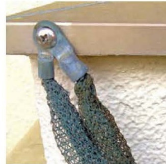
↑写真11 / 基台からの網線を金属部分へネジ止め。
