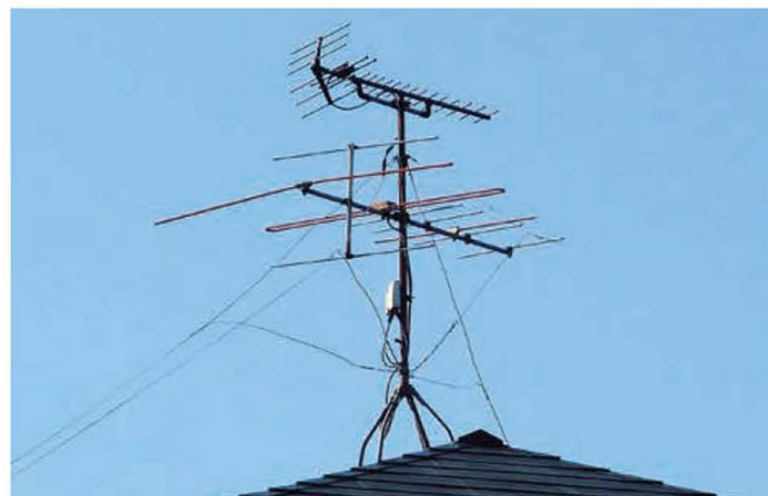
↑写真8 / 2011年にアナログ・テレビ放送が終了してもVHF+UHFアンテナとV/U共用受信ブースターで受信している事例もある。受信ブースターの感度分布は地デジ用に比べ広域と同時に、錆や腐食でアンテナの受信性能低下に要注意だ。
